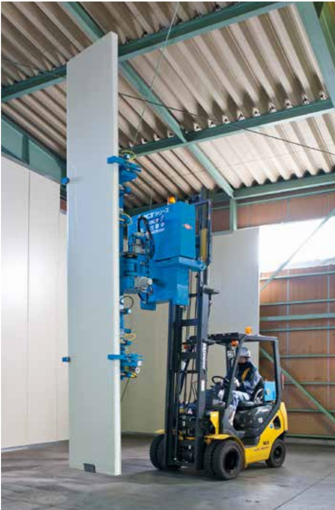
施工支援ロボット「i-OCT」による現場での作業風景
