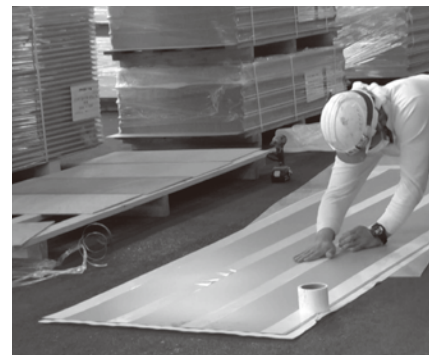
③鋼板の裏に両面テープを接着
