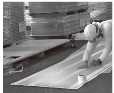
③ 鋼板の裏に両面テープを接着
