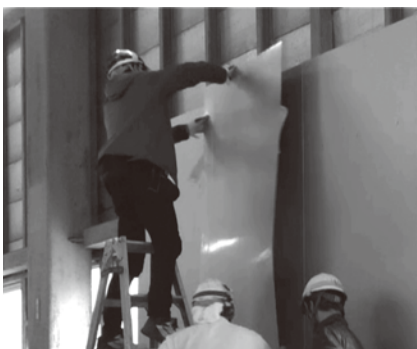
④ 変形したパネル上に貼り合わせる
