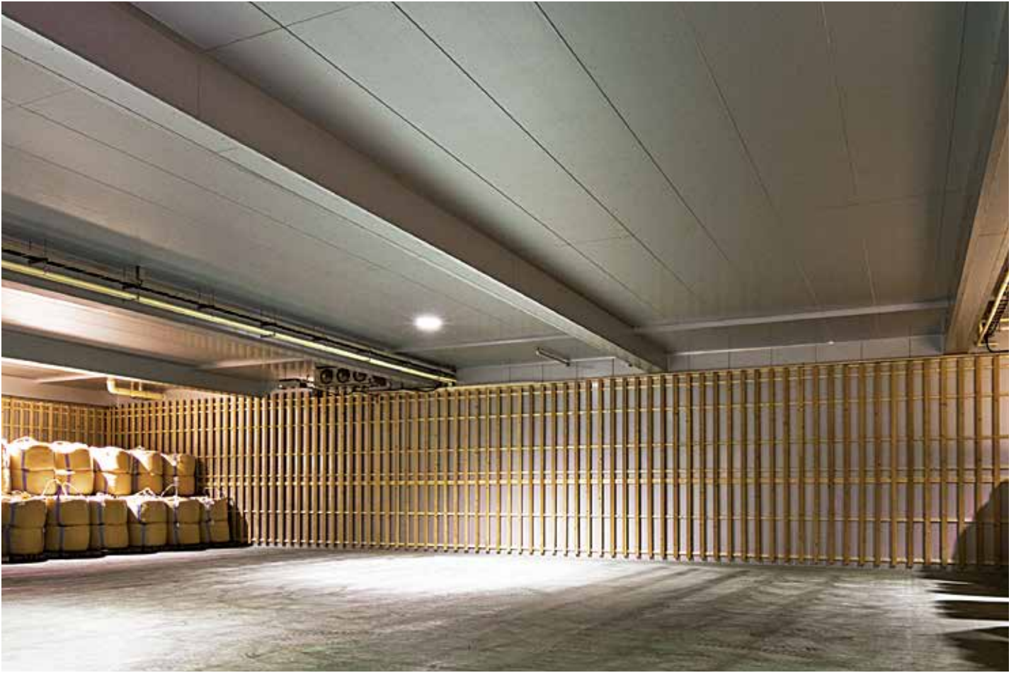
米倉庫：内壁・天井（スタイロウォール：スプラインジョイント）
