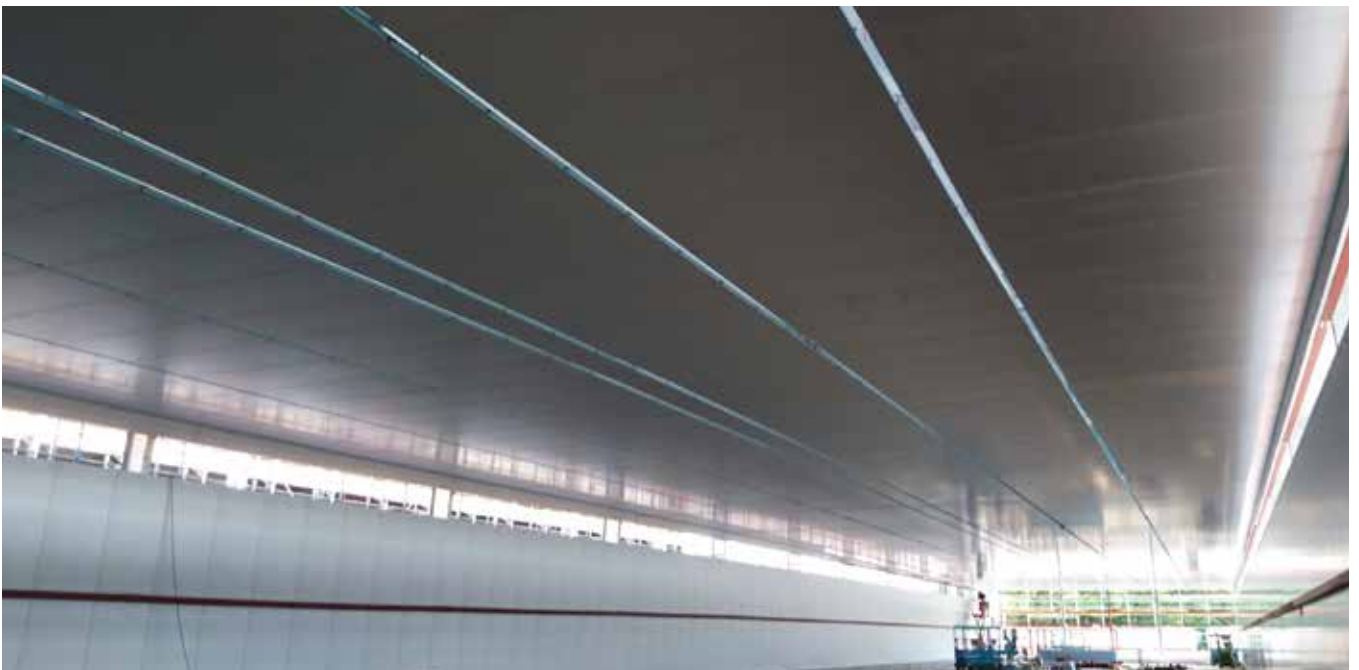
鶏舎：外壁（スタイロウォール：スリップジョイントS2）／天井（スタイロルーフ）
