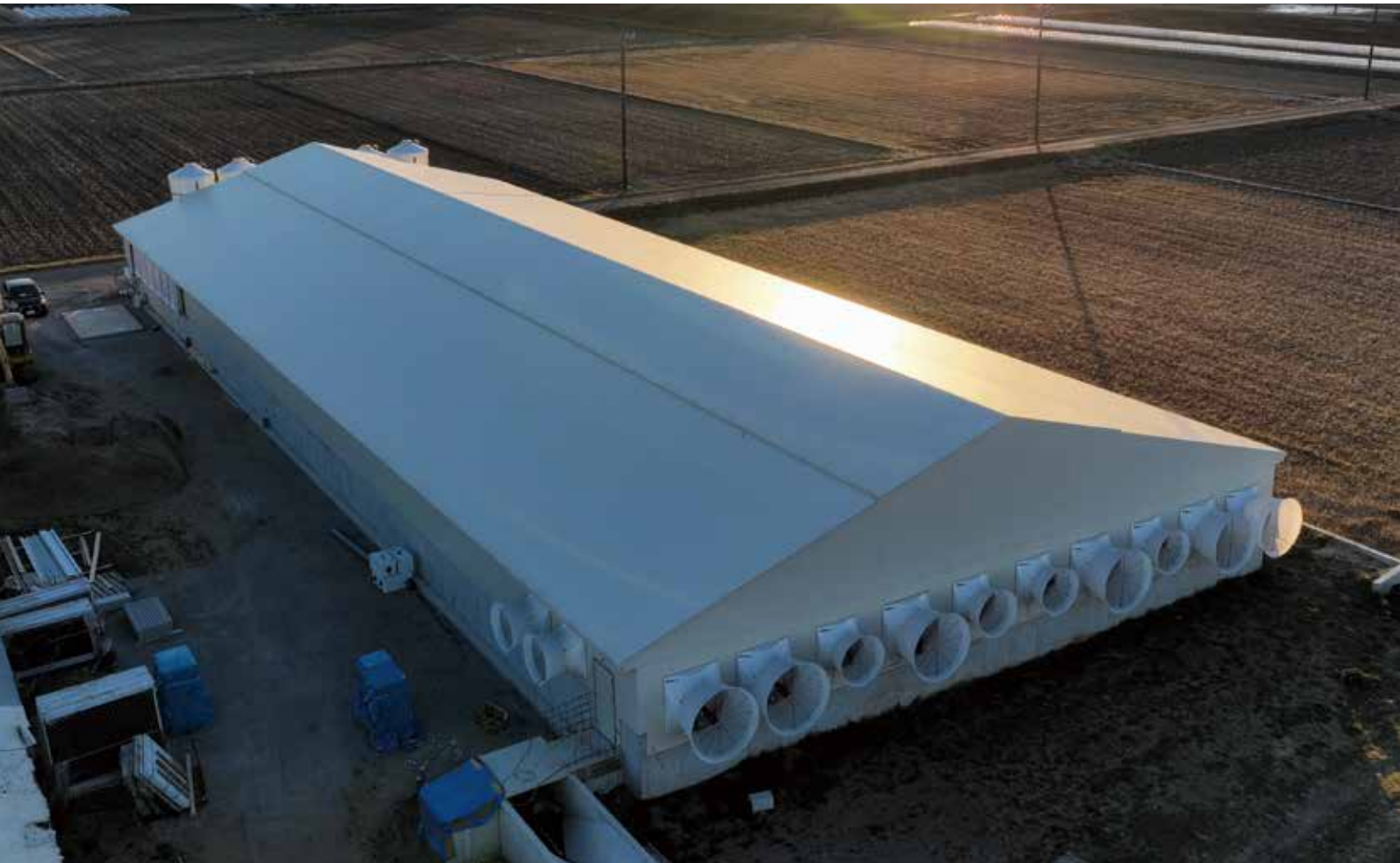
豚舎：屋根（2ダンルーフ）／外壁・天井（スタイロウォール：スリップジョイントS2）
