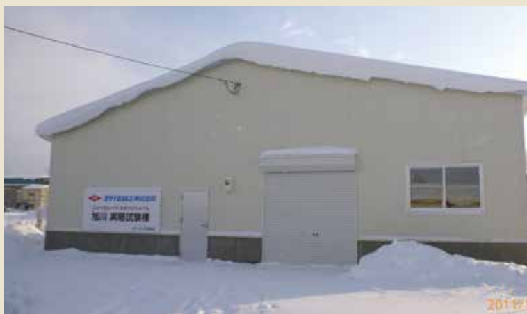
北海道旭川暴露試験棟
