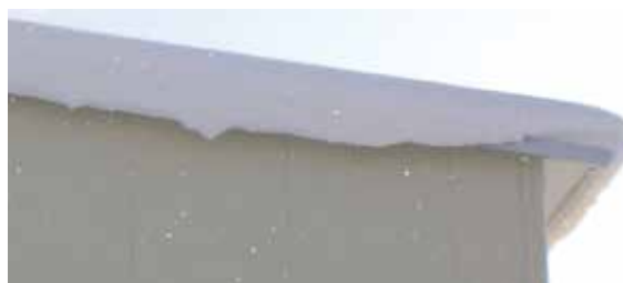
北海道旭川曝露試験棟
