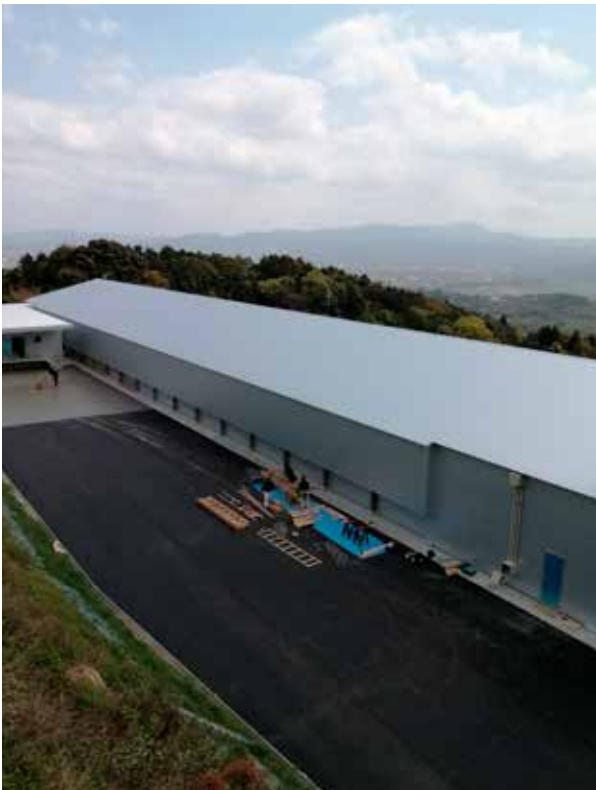
鶏舎：屋根（スタイロルーフ） 外壁（スタイロウォール：スリップジョイント S2）
