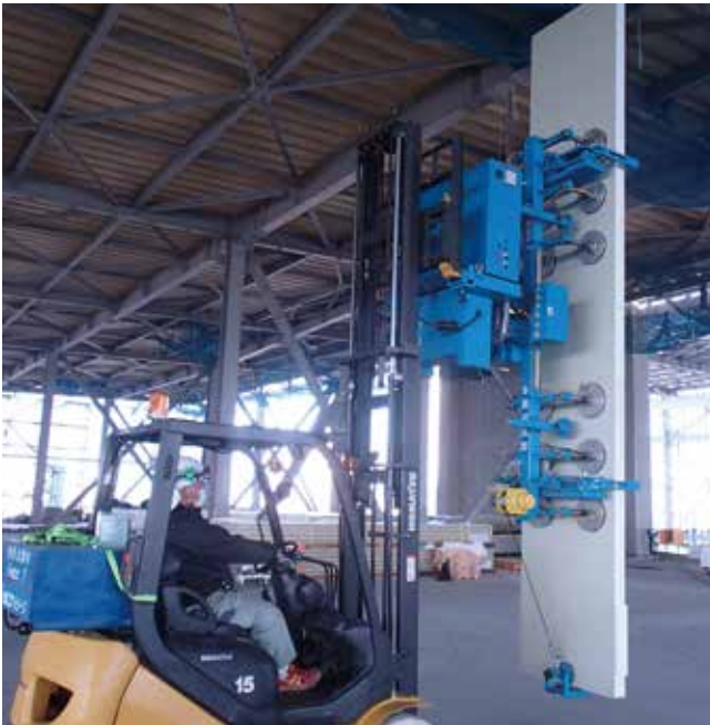
ロボットによる現場での作業風景
