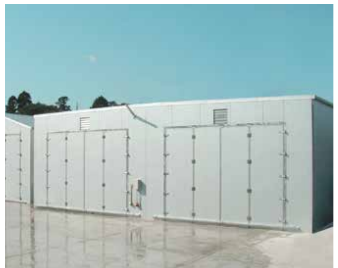
キノコ栽培施設：外壁（スプラインジョイント）
