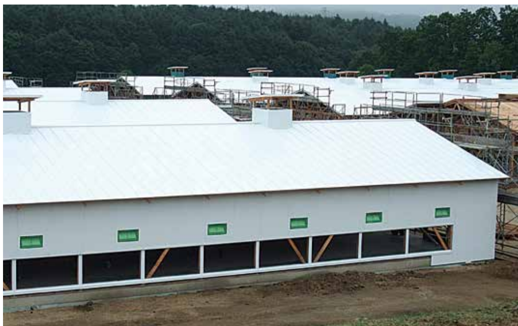
鶏舎：外壁（スリップジョイント S2）
