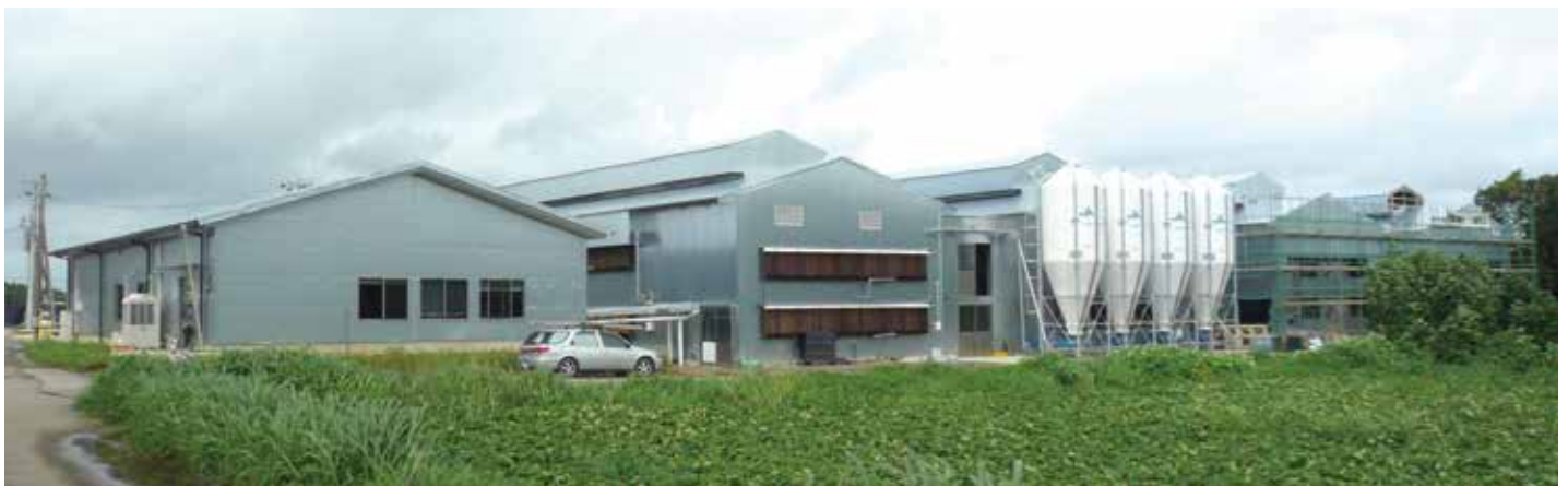
鶏舎：外壁（スリップジョイント S2）
