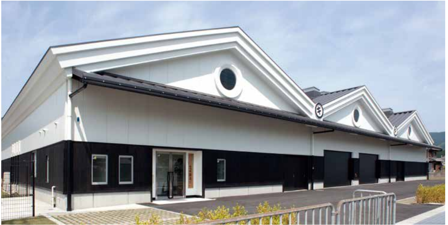
醤油醸造工場：外壁（ボルトレス B3）
