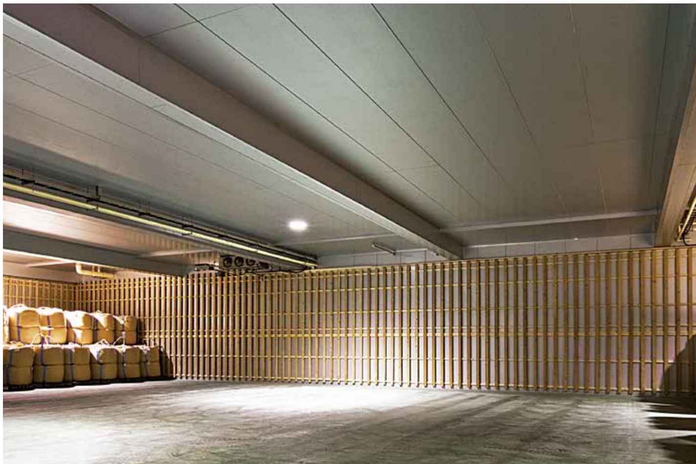
米倉庫：内壁・天井（スプラインジョイント）
