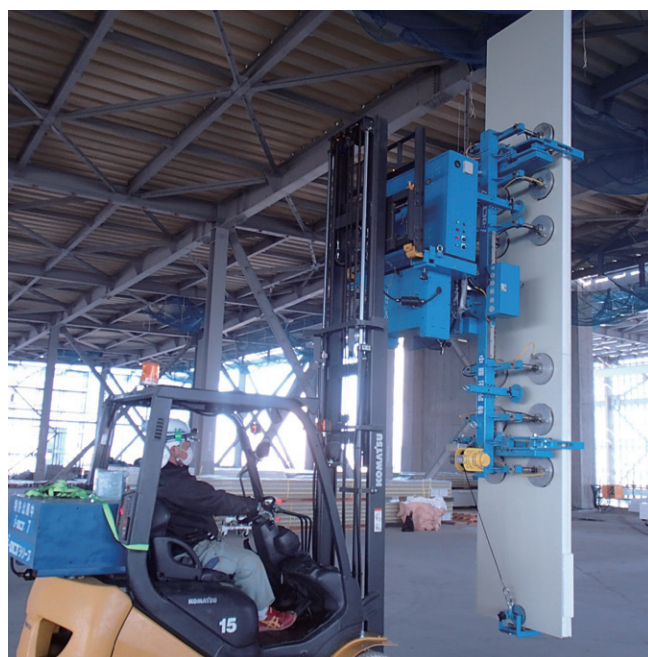
ロボットによる現場での作業風景
