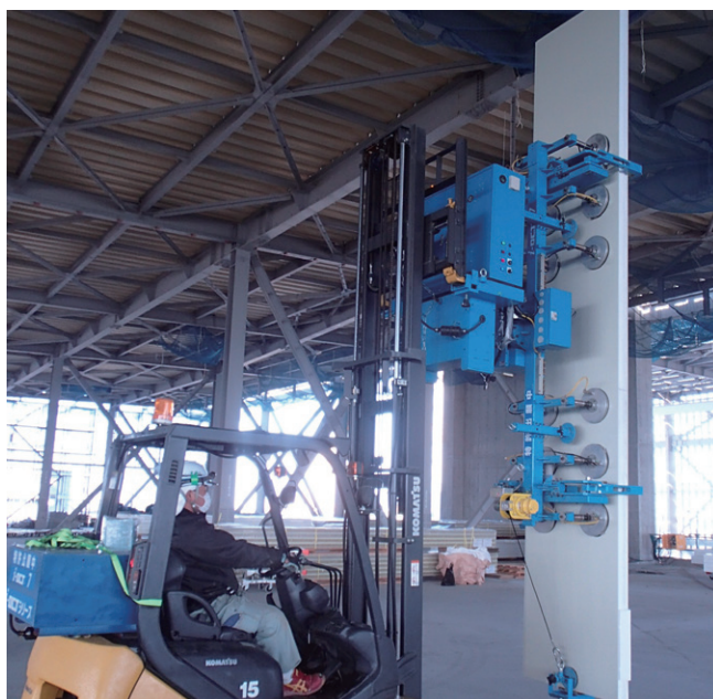
ロボットによる現場での作業風景
