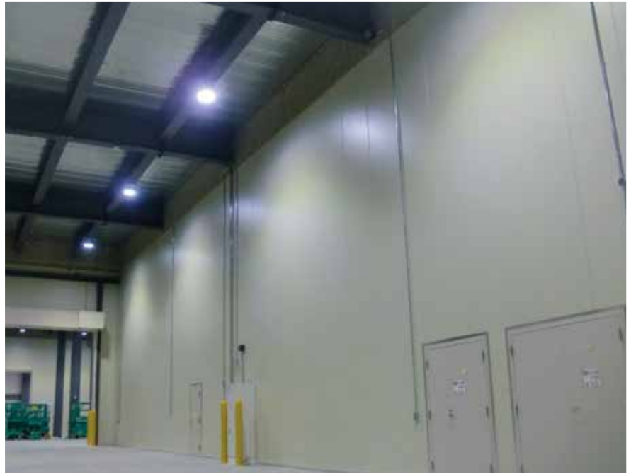
医療関係工場の間仕切壁
