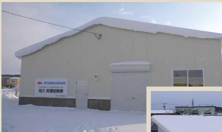
北海道旭川曝露試験棟
