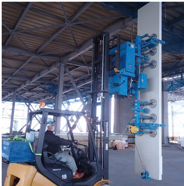
ロボットによる現場での作業風景
