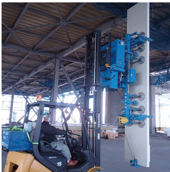
ロボットによる現場での作業風景
